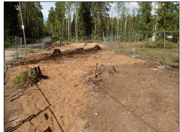
ja alue on siistitty ja tasoitettu
