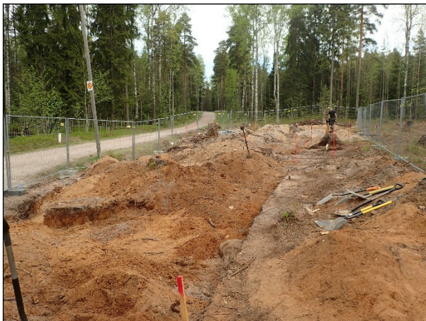
Kaivaus on päättynyt
